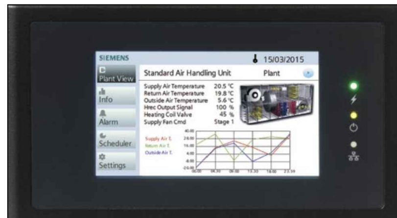
ПАНЕЛЬ УПРАВЛЕНИЯ УСТАНОВКОЙ
